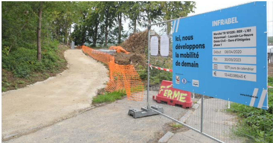
Le chantier en cours, près du parking des Villas.
