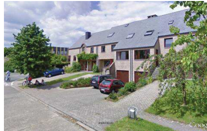
Photo 16 - Avenue de Cîteaux
