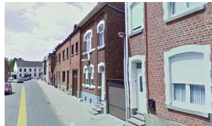
Photo 24 - rue Louis Sablon
